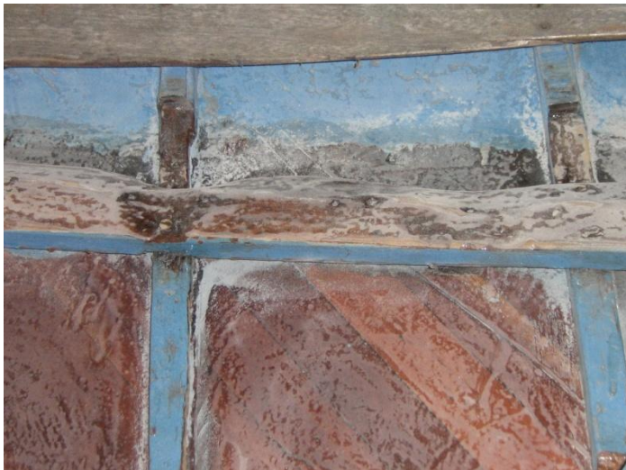
Schleifarbeiten im gesamten Innenbereich
